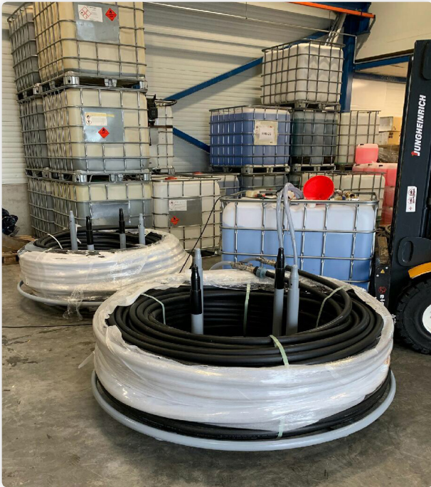
Påfyllnad av kollektorslang
